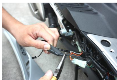
鉗子壓緊熱溶膠束管
